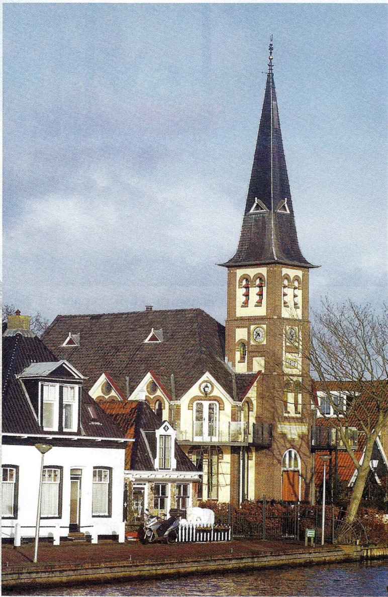
Appartementen in de voormalige gereformeerde kerk van Woudsend (foto: persbureau Noordoost)
